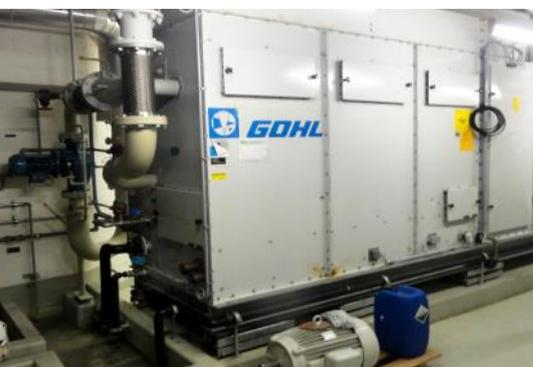
Kühlturm ist mit Nachspeisung, Heizung und Frostschutzfunktion ausgerüstet.
